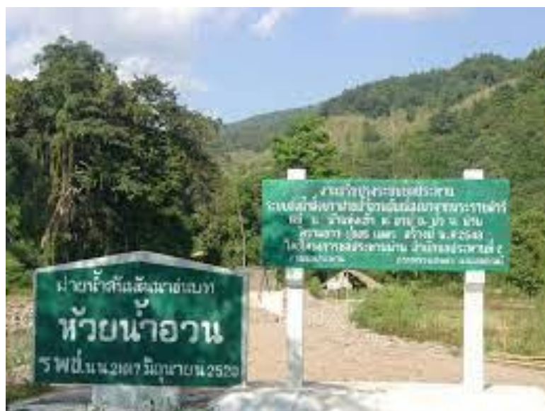
ภาพที่ 2.7 โครงการปรับปรุงระบบส่งน้ำฝายขวาฝายน้ำอวน
